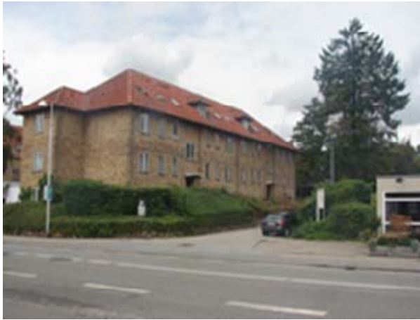
DSC00449 Bistruplund bygn 1 østfacade sydgavl
