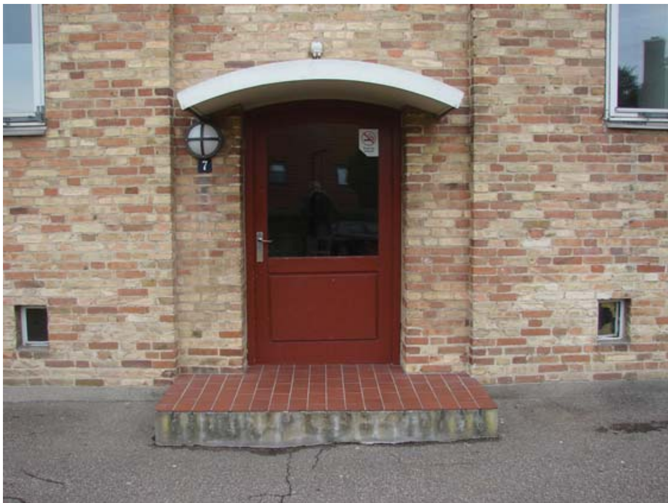
DSC09663 Bistruplund hoveddør med repos
