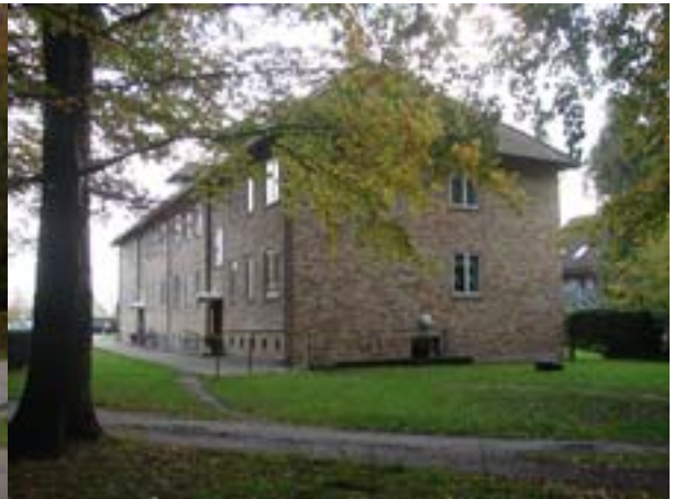
DSC00065 Bistruplund bygn 5 nordgavl
