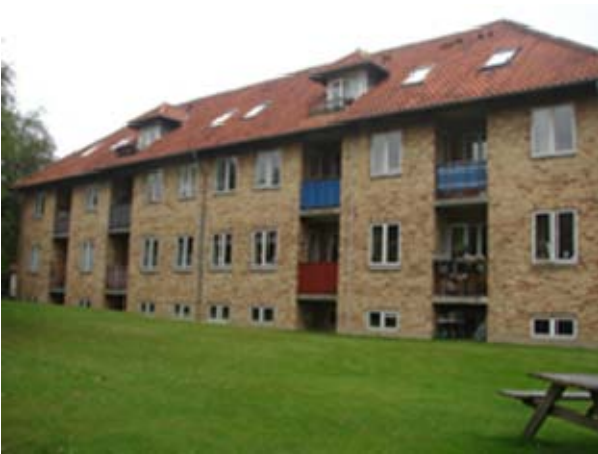
DSC09679 Bistruplund bygn 3 vestfacade
