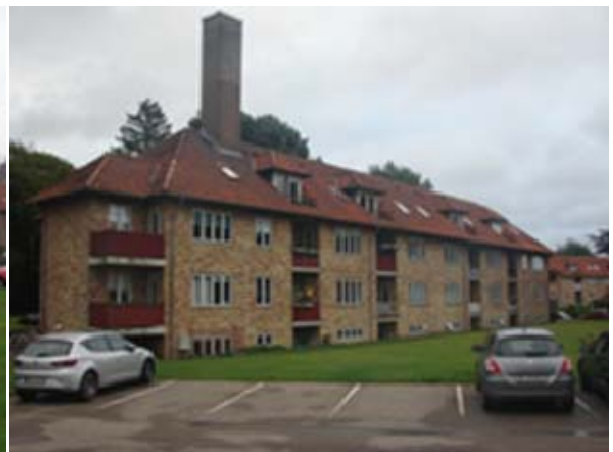
DSC00586 Bistruplund bygn 6 vestfacade
