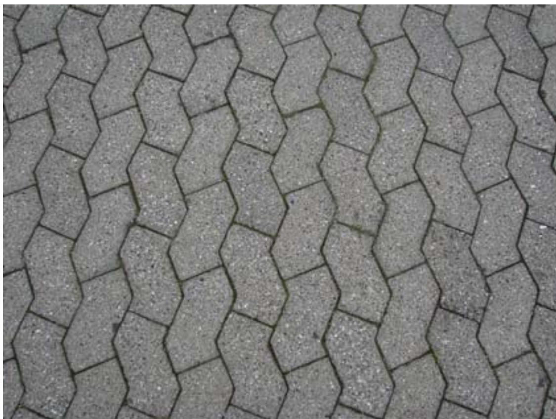
DSC09767 Flisebelægning tørreplads øst
