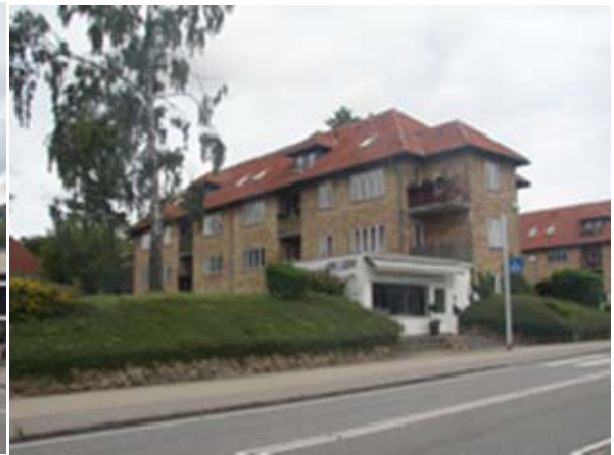
DSC00453 Bistruplund bygn 1 vestfacade
