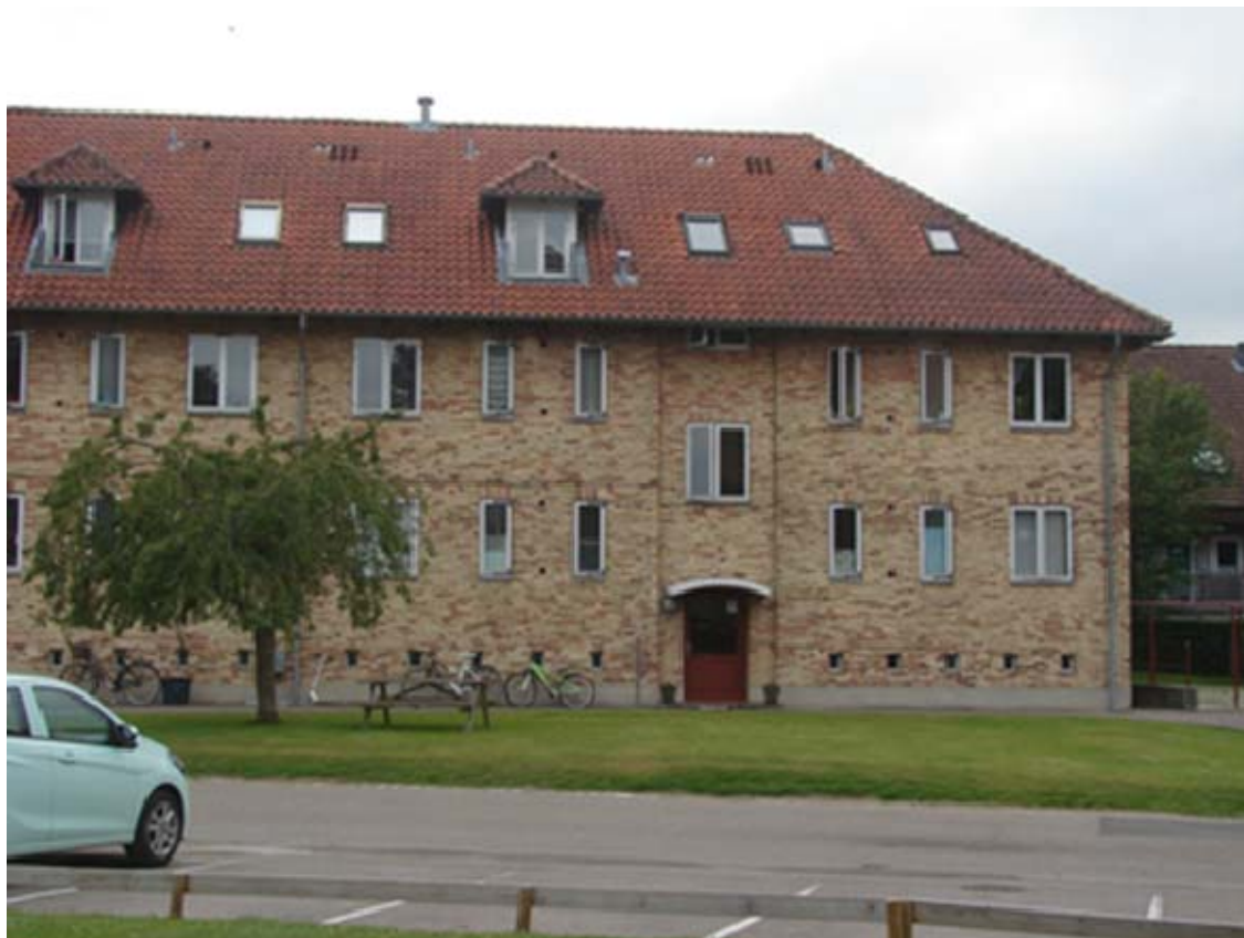
DSC09711 Bistruplund 4 østfacade med ovenlysvinduer
