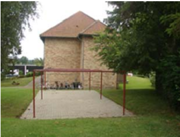
DSC09682 Bistruplund bygn 1 nordgavl
